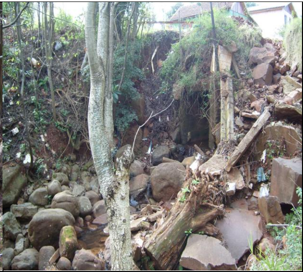
FOTO 02 – Córrego em Travessia Urbana
