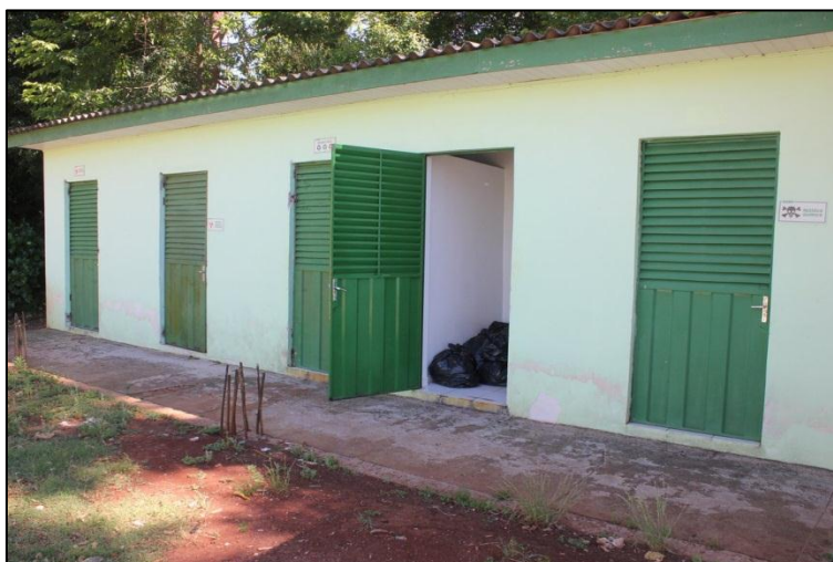
Figura 32 – Local de acondicionamento dos RSS na Associação Hospitalar Bom Pastor.
