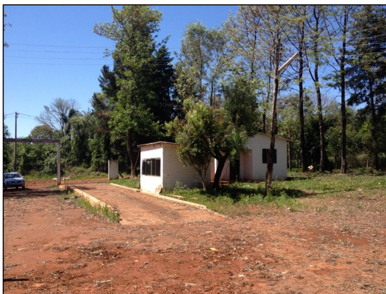
Figura 34 – Vista da balança e residência existente na área da UTAR.
