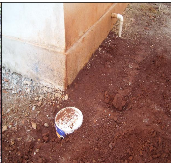
FOTO 02 – Instalações Operacionais de Coleta
